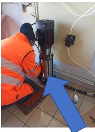
Cet automne, nous avons changé le supprimeur d'eau pour l'injection automatique de chlore en sortie de captage.
